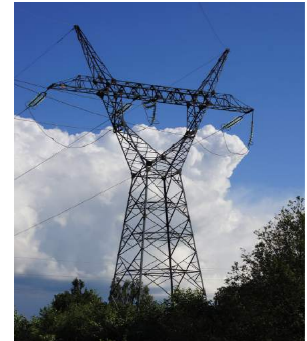
Stopyt linii NN typu „mocnego” utrzymujący napięcie przewodów
