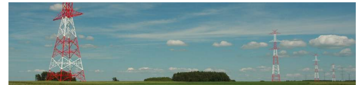
Widok linii z malowaniem ostrzegawczym
