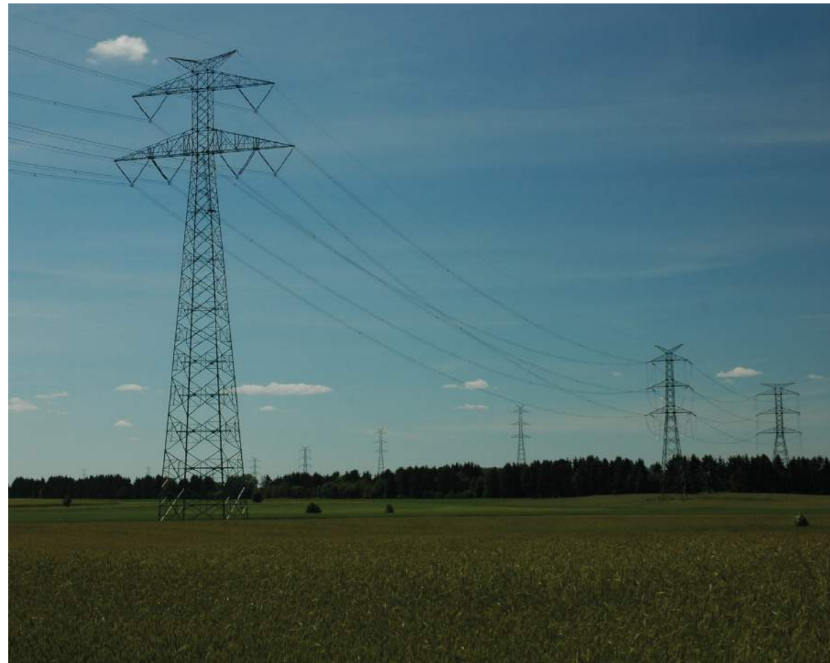
Linia 2x400 kV w terenie
