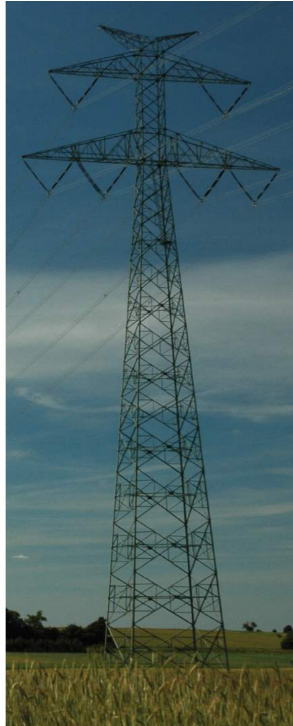
Budowa linii 2x400 kV
