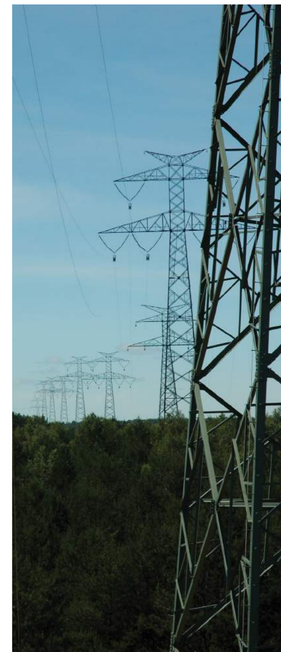
Linia NN w wykonaniu nadleśnym
